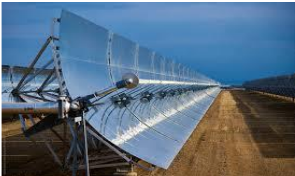
Gambar 2.14. Kolektor Surya Palung Parabola
