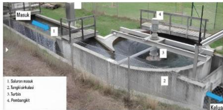
Gambar 2. 4 Sistem pembangkit listrik turbin vortex Sumber : (Perdana,2022)
