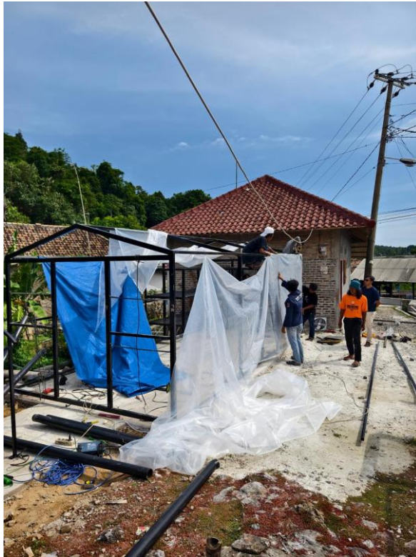
Gambar 3.19 Pemasngan plastik UV dan gas heater .
