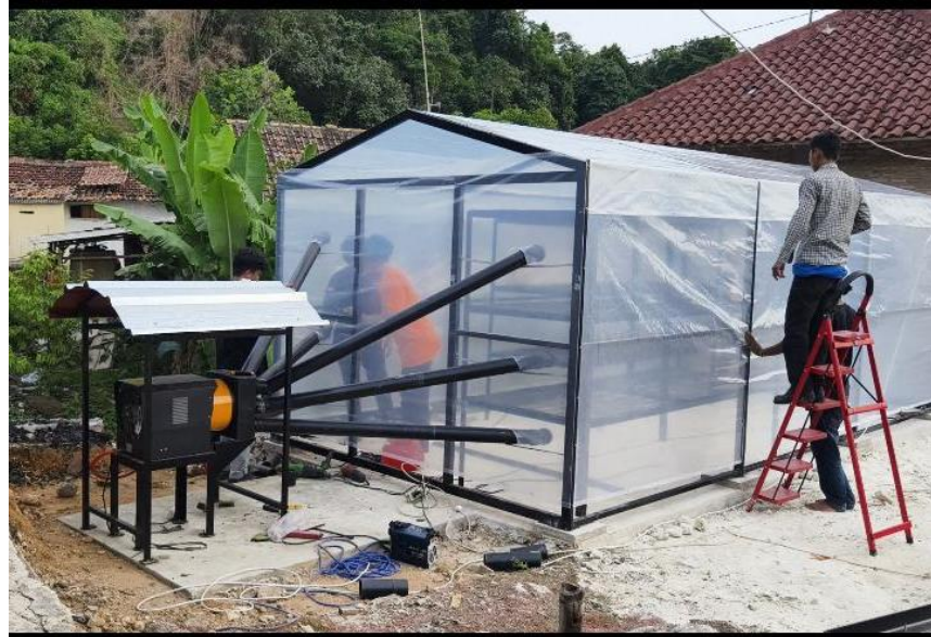
Gambar 3.20 Proses Instalasi elektrik dan fishing mesin pengering.
