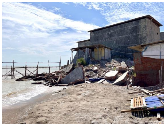
Gambar 4. Kondisi salah satu rumah di pesisir Kabupaten Karawang
