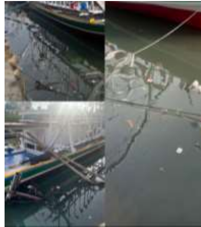
Gambar 3.1 Kondisi Muara Sungai Way Belau di Pulau Pasaran, Kota Bandar Lampung (Dokumentasi Pribadi, 2025).
