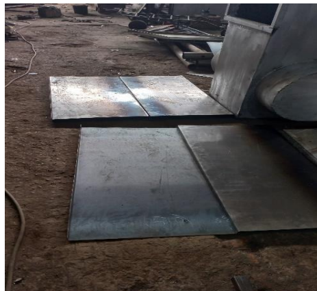
Gambar 3. 4 Pembuatan dinding pengering dari plat 2,5 mm.
