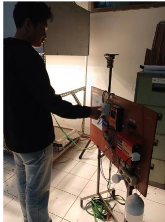
Gambar 3.24 Pemasangan Sistem Kelistrikan
