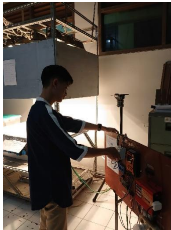
Gambar 3.23 Pemasangan sistem kelistrikan
