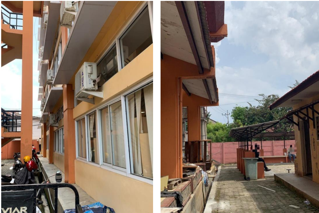
Gambar 4. 2 Samping Gedung E dan Belakang Gedung Ilmu Komunikasi
