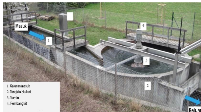
Gambar 2.3 Sistem pembangkit listrik turbin vortex (Bajracharya, 2020)
