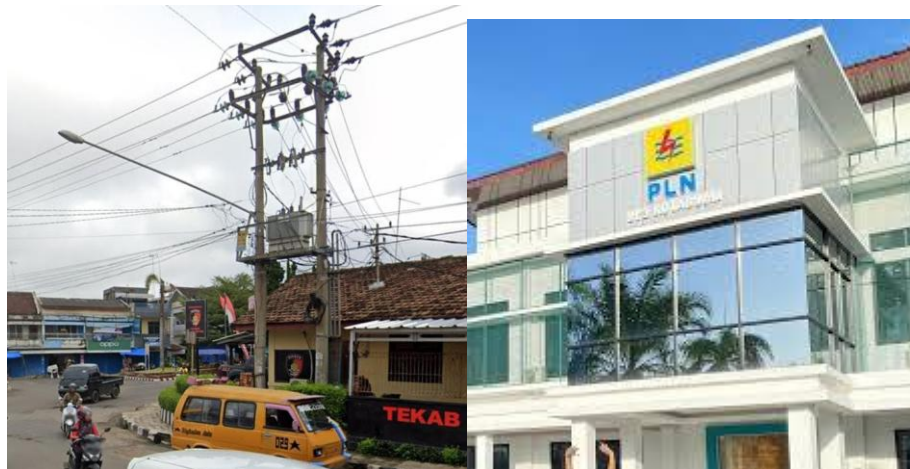
Gambar 16. Prasarana jaringan listrik
