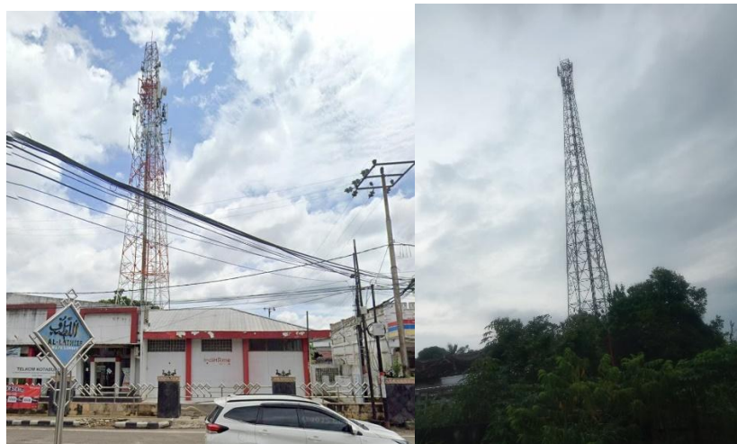
Gambar 17. Prasarana jaringan telekomunikasi
