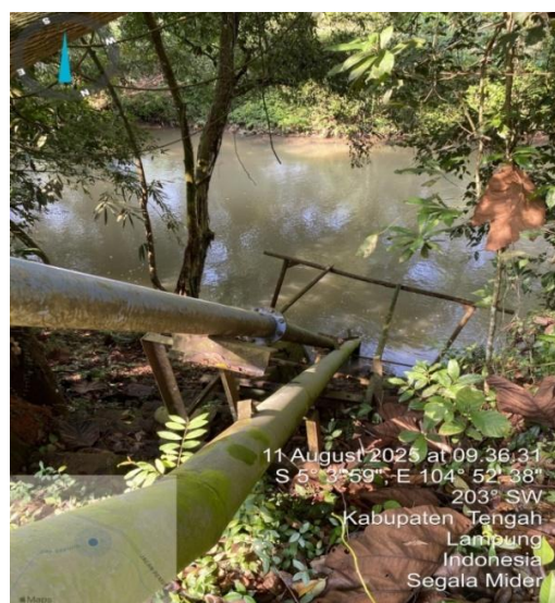
Gambar 5. Pipa Pembuangan Limbah Cair ke Sungai Sumber: Dokumentasi Pribadi, (2025)
