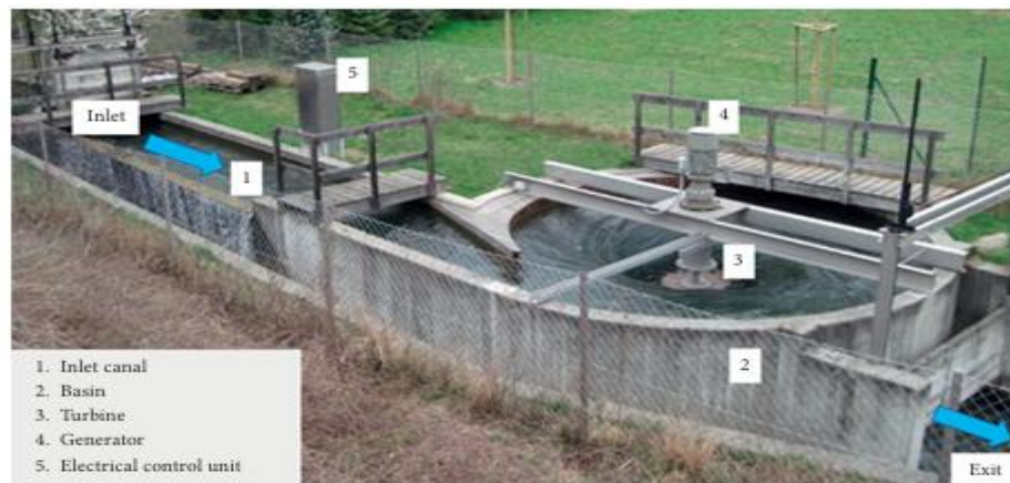
Gambar 2. 5 Sistem pembangkit listrik turbin aliran vortex (Bajracharya et al, 2020).
