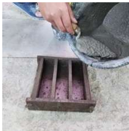
Gambar 3.23. Memasukkan campuran mortar.
