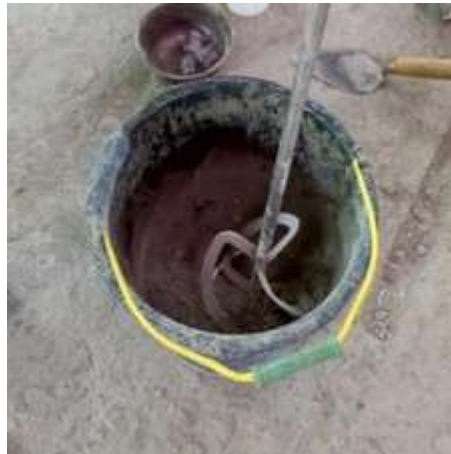
Gambar 3.17. Mencampurkan semen dan pasir.
