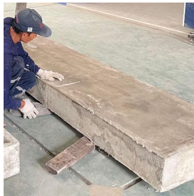
Gambar 39. Membuka cetakan benda uji.
