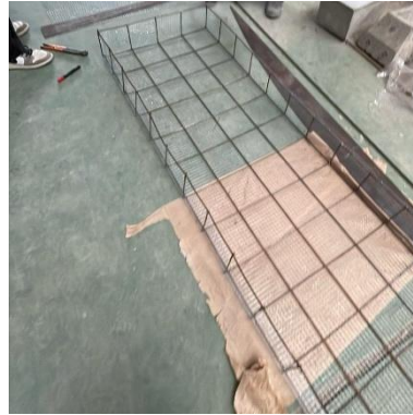
Gambar 8. Penulangan panel ferosemen.
