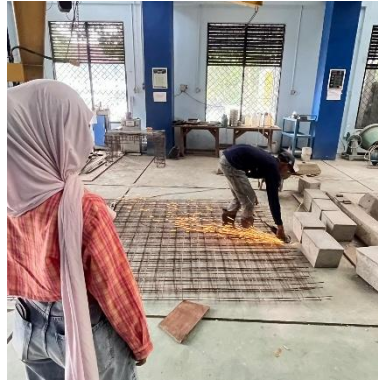
Gambar 34. Pemotongan tulangan wire mesh .
