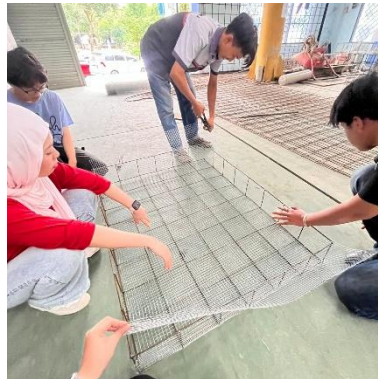
Gambar 35. Pemasangan kawat ayam pada tulangan panel.
