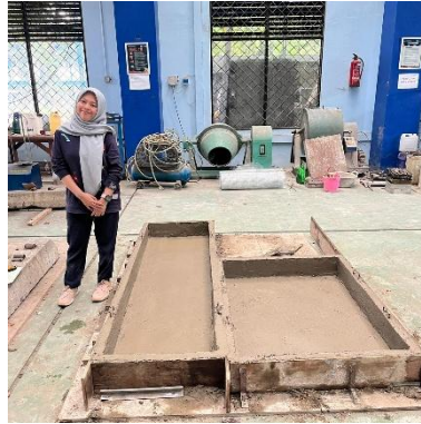
Gambar 38. Memasukkan campuran ferosemen pada cetakan.
