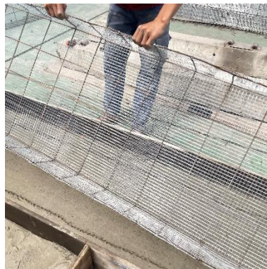
Gambar 37. Meletakkan rangkaian tulangan pada cetakan.
