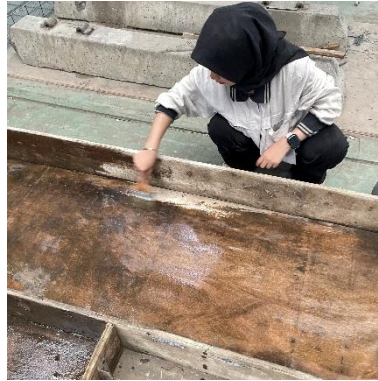
Gambar 36. Menyiapkan cetakan panel fero semen.
