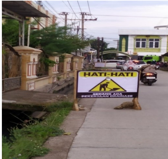
Gambar 1. Kegiatan pembangunan drainase yang sedang berlangsung di Kecamatan Sukarame.
